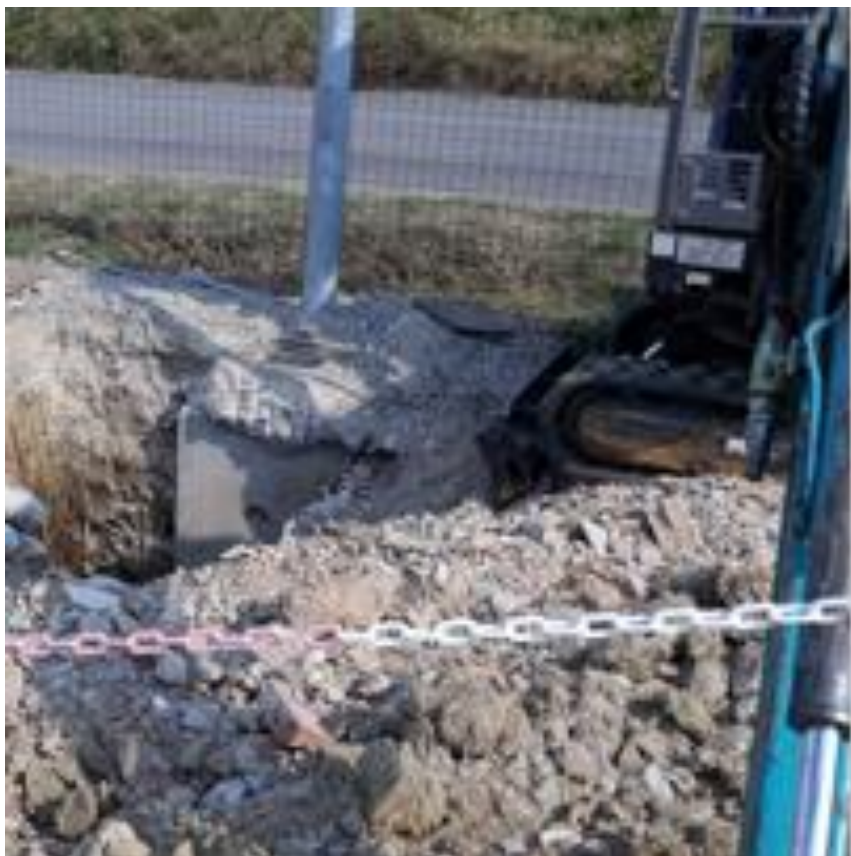
Fig. 28 - Momenti del ripristino del danneggiamento
