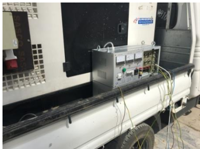
Figura 12 – Trasformatore di PC
